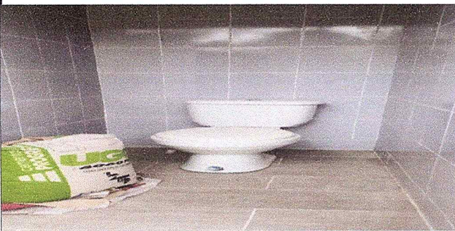
Foto 3: COLOCACION DE TAZAS SANITARIAS Y ACCESORIOS
