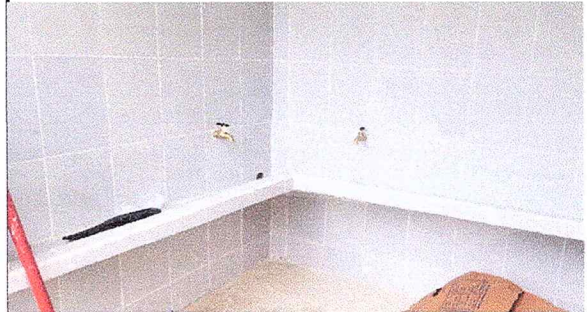
Foto 2: COLOCACIÓN DE AZULEJOS
