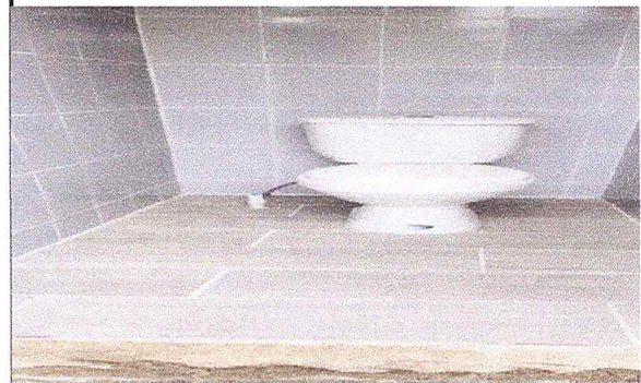
Foto 4: COLOCACIÓN DE PISO CERAMICO Y RELLENO
